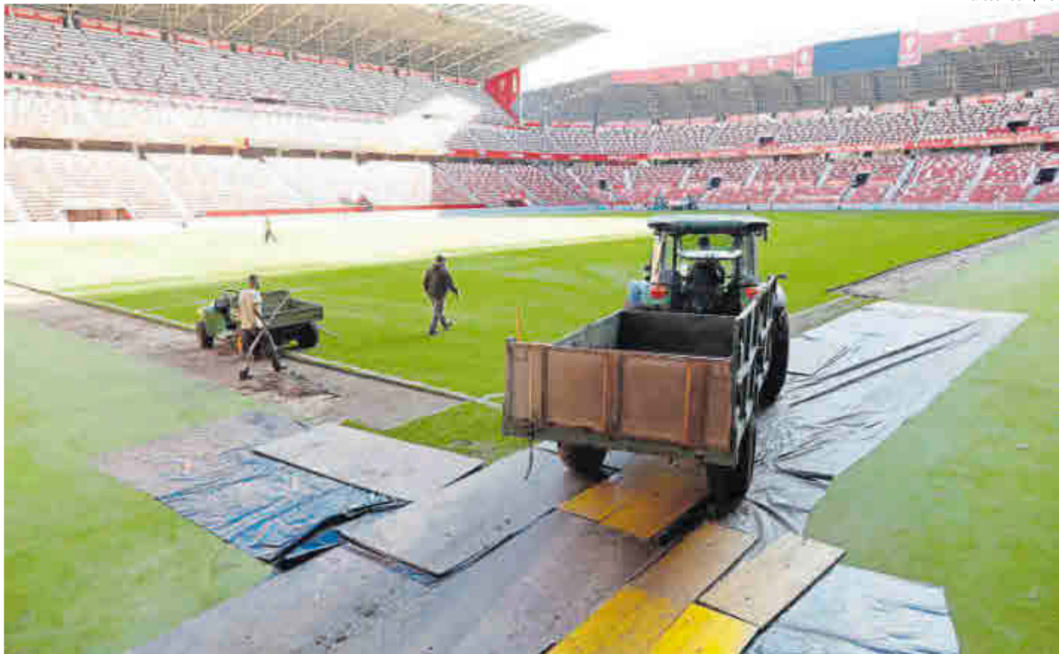
Operarios, durante los trabajos, ayer, en el césped de El Molinón.
